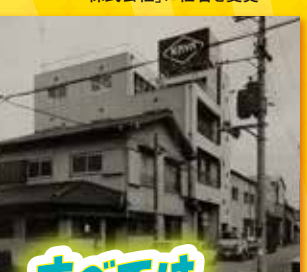
昭和48年(1973)、4階建ての新社屋を建設。「向陽技研株式会社」に社名を変更
